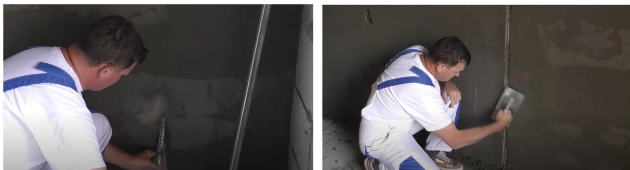
Рис. 29. Схема демонтажа маяков и заделки образовавшихся борозд
