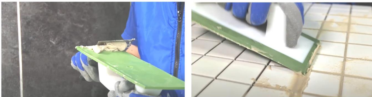
Рис. 38. Заполнение швов затиркой при помощи резинового шпателя
